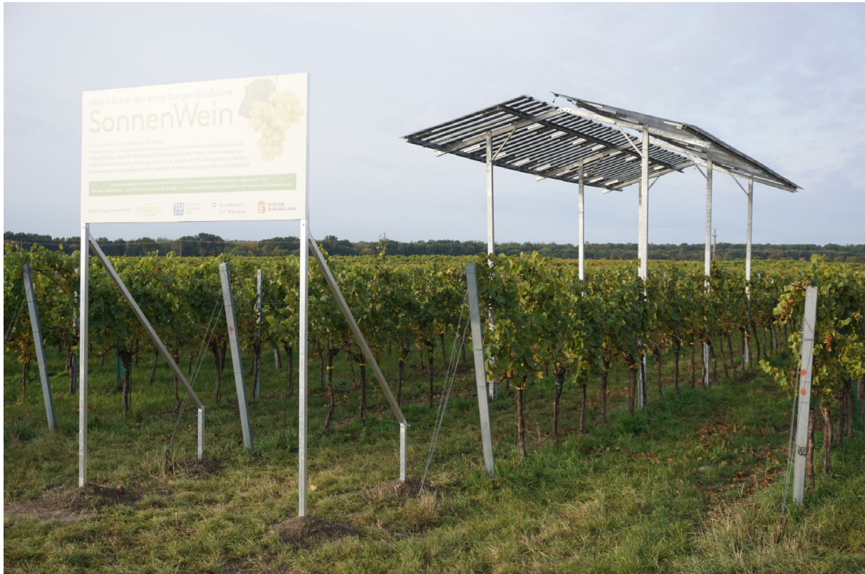
Abb. 3: Chardonnay-Weingarten in Donnerskirchen, teilweise von einer Photovoltaik-Anlage beschattet.
